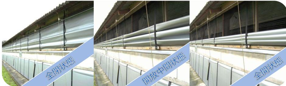
変更後：中間巻上げ吊上げ式カーテン(KS-Kタイプ)
